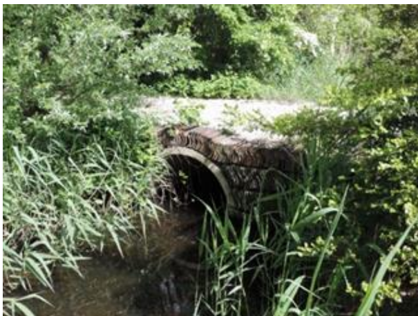
Een dammetje met duiker voorzien van een beschoeiing van oude dakpannen.
