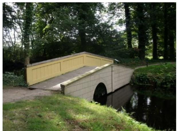
Bij bruggen vraagt ook de aansluiting met het pad de nodige aandacht en onderhoud.
