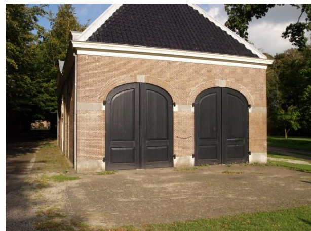
Kleine onregelmatigheden door zettingen in verharding dragen bij aan het gevoel van authenticiteit; herstel is alleen nodig als dat voor de instandhouding noodzakelijk is.
