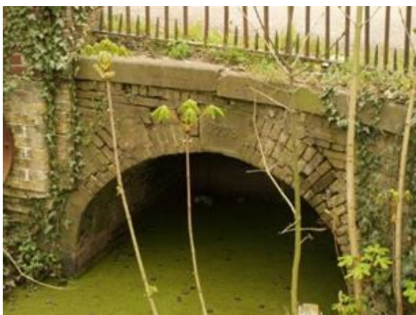
Een oud, sterk vervallen 18 e eeuwse sluisje. Restauratie van monumentale bouwkundige elementen is specialistenwerk..
