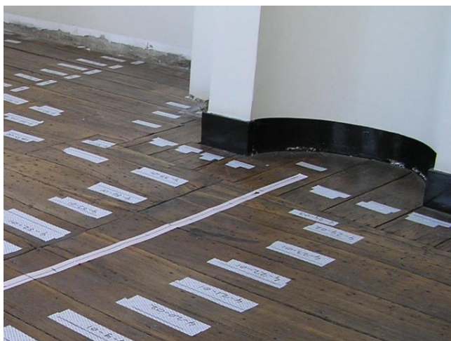
Afb.7 en 8: Identificeren en vastleggen van de locatie van de uit te nemen onderdelen voorafgaand aan werkzaamheden. Ieder plankje of strook krijgt een eigen identificatienummer.
