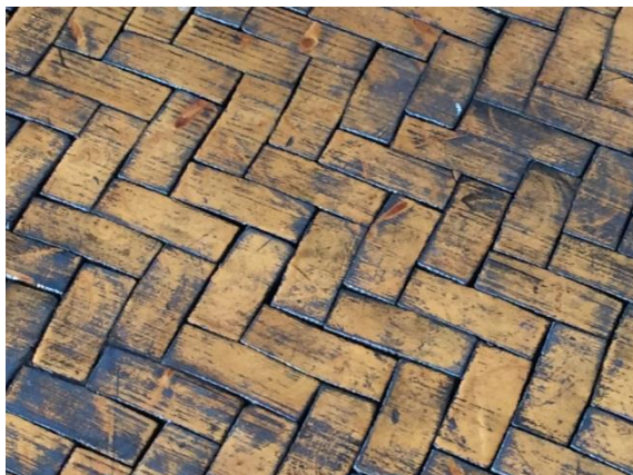
Afb. 21 en 22: detailfoto's van een parketvloer met zeskantige blokjes kopshout in teer gelegd en een vloer met rechthoekige blokjes in visgraatverband. Laatstgenoemde is het meest voorkomend.
