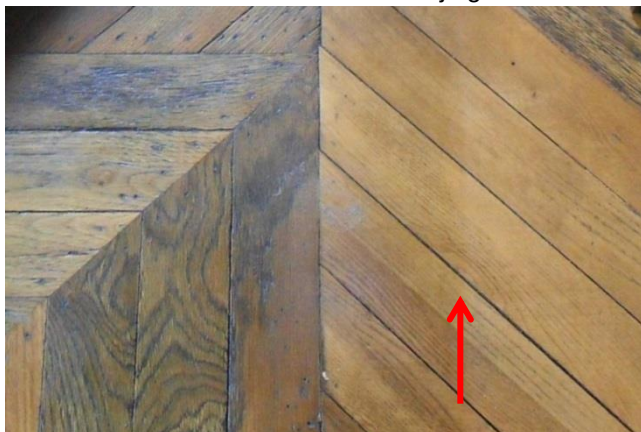
Afb. 5: lichtschade, aftekening van teruggeslagen tapijtrand.
