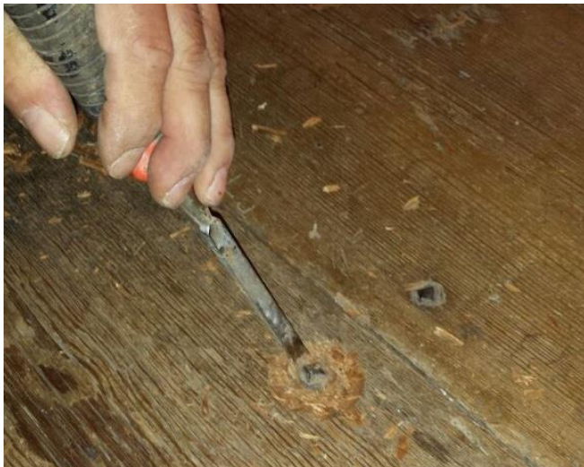
Afb. 18: Nagels moeten gemakkelijk te verwijderen zijn zonder dat daarbij het hout wordt beschadigd wanneer parket uitgenomen moet worden. Hier wordt de omgeving met een beitel (lelijk) vrijgemaakt. Dat is in conflict met de zorgvuldige aanpak.
