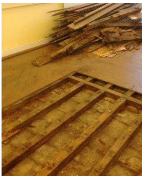
Afb.9: 'uitnemen' van een houten vloer. De opstapeling in dezelfde ruimte duidt op het geheel vernieuwen van de vloer.
