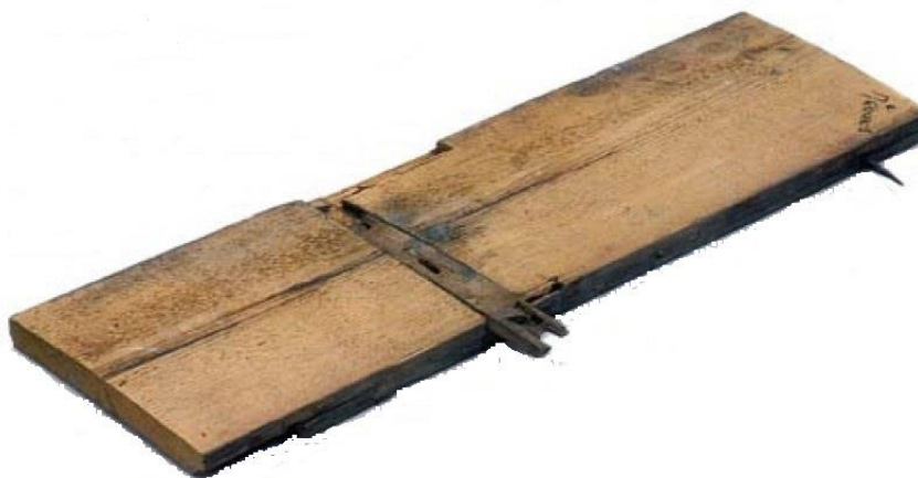
Afb.4: onderaanzicht van een zeventiende-eeuwse plank. Links van het midden is een wig zichtbaar, die op de balk gespijkerd wordt. Door de plank over de wiggen te schuiven wordt de plank, "blind" en zonder te spijkeren, aan de balken bevestigd.
