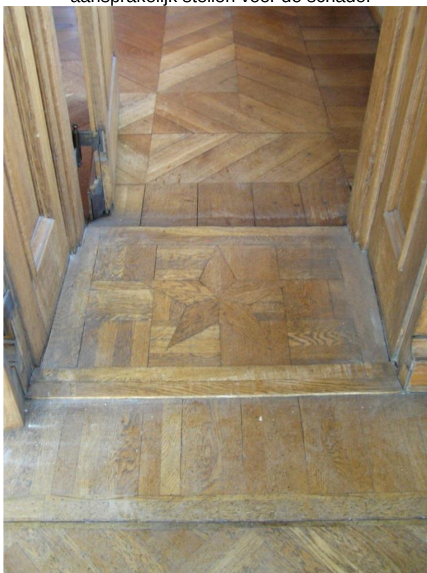
Afb.16: detailfoto van een doorgang in een interieur waar verschillende parketvloeren en patronen samenkomen.
