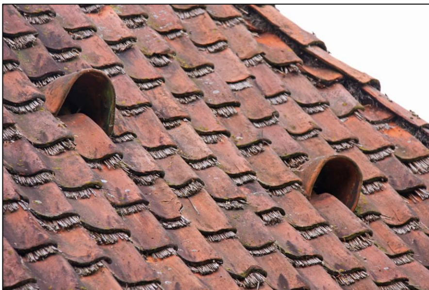
Een zojuist opgeleverd historisch pannendak voorzien van strodkoppen, met twee licht- of luchtpannen.
