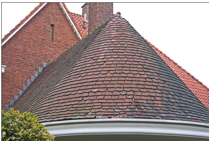
Een dak van een serre van een woonhuis uit circa 1930, belegd met leipannen in twee vormen.
