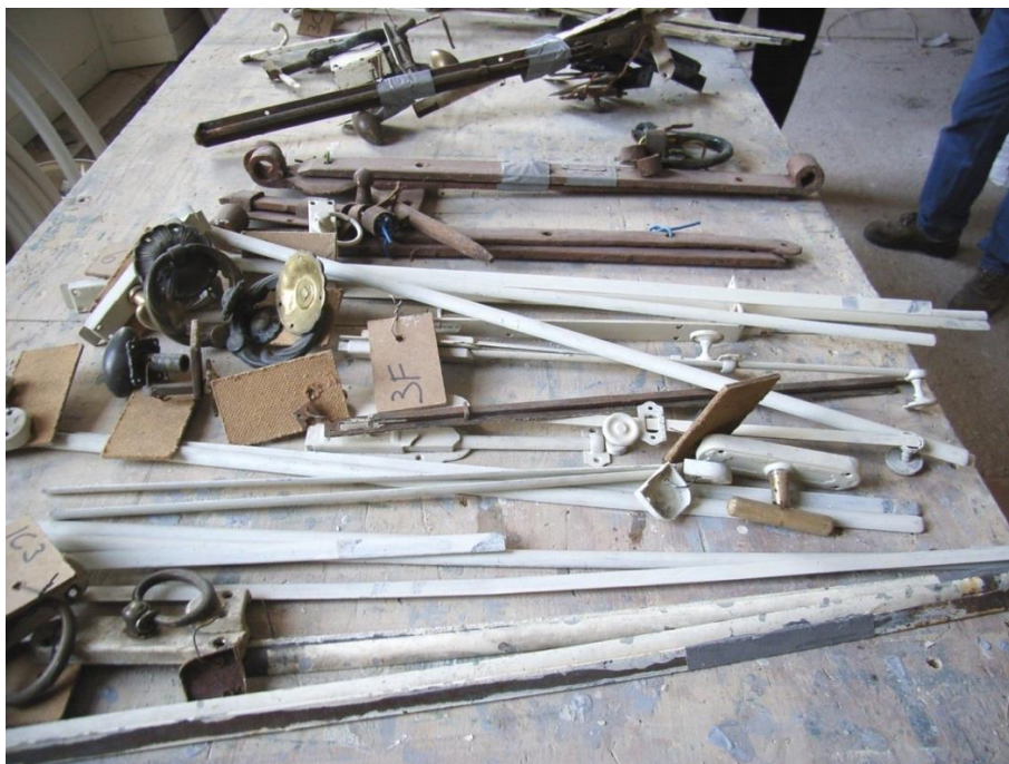
Afgenomen hang- en sluitwerk zijn voorzien van labels met codes, waardoor de herkomst per bouwdeel vastligt. Hierdoor kan later hergebruik op de juiste plek plaatsvinden.
