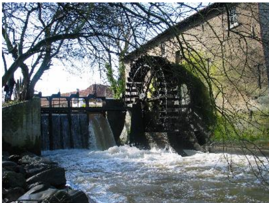
Links de Ophovener molen te Sittard. De molen levert al vijftien jaar 24/7 groene stroom in een omvang van 45.000kWh/jr. Dat doet hij overigens niet met het oude scheprad, maar met een onzichtbare onderwaterturbine. Rechts het interieur van een kleine monumentale krachtcentrale uit 1919, die al 25 jaar zo'n 150-200 megawatt per jaar aan stroom produceert. Waterkracht is in Limburg een kansrijke leverancier van groene stroom! © BAT-Sittard
