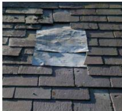
Herstel leiwerk conform bestaande toestand: vergunningvrij
