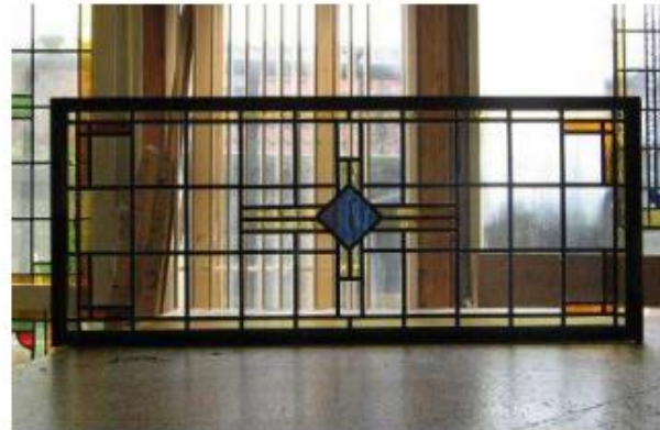
Glas-in-loodraam uitgenomen, hersteld en met dezelfde glassoort teruggeplaatst: vergunningvrij
