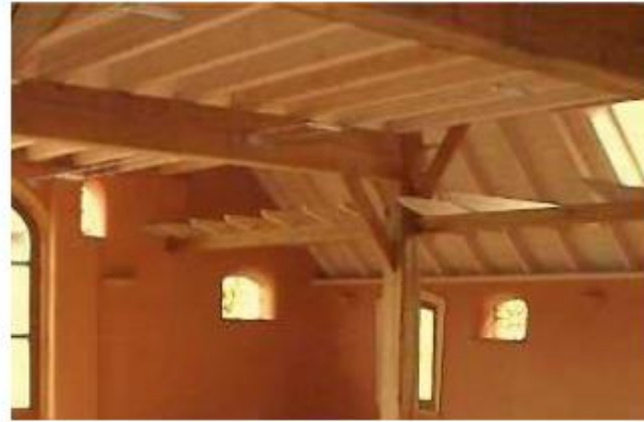
Aanbrengen binnenisolatie. Vergunning nodig.
