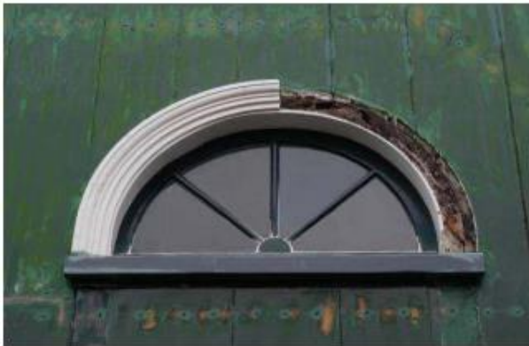
Herstel houtwerk vergunningvrij als detaillering, profilering, vormgeving, materiaalsoort en kleur dezelfde blijven
