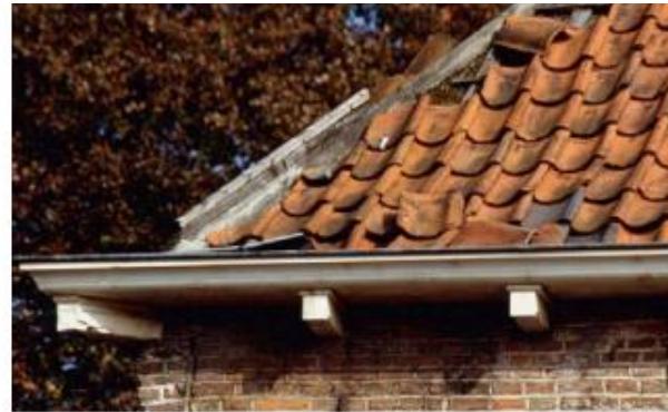
Herstel lood en pannen conform bestaande toestand: vergunningvrij
