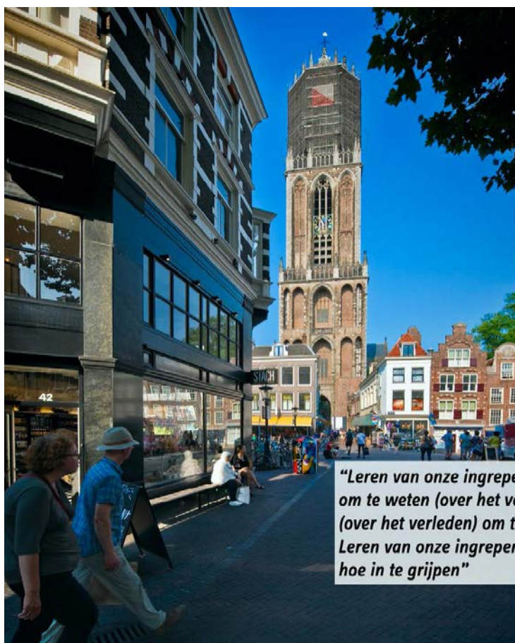
Restauratie Domtoren, Utrecht.
