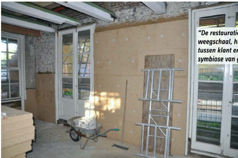
Het aanbrengen van dampopen isolatie bij landgoed Duijnwijck, Beverwijk.
