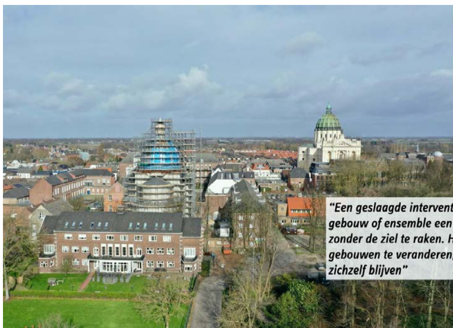
Restauratie exterieur kapel Saint Louis, Oudenbosch.
