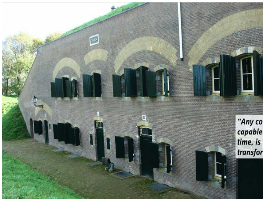
Restauratie Fort Giessen.
