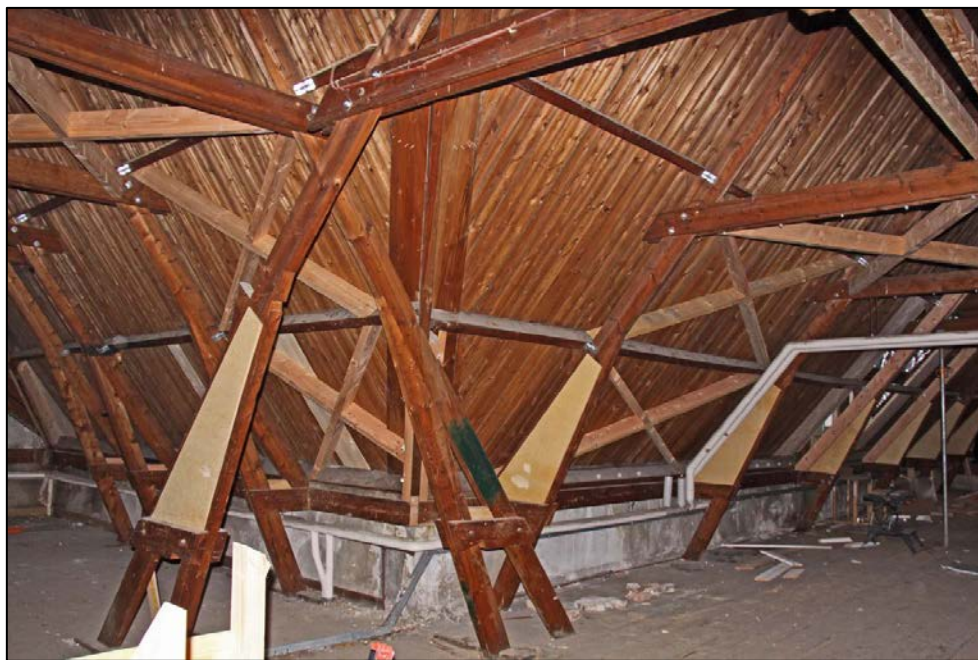
In verband met intensiever gebruik van de kapruimte is de spantconstructie verstevigd om te voldoen aan de eisen voor constructieve veiligheid.
