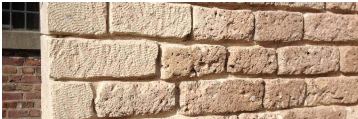
Imiteren. De paramentblokken aan de kerk van Hellendoorn waren van Römer tuf (rechts) en zijn deels vervangen door blokken Weiberner tuf (links). De blokken Weiberner zijn afgewerkt met een tandijzer (links). Deze afwerking was niet aanwezig op de oude omgeving en is uitgevoerd om de nieuwe tufsteen visueel aan te laten sluiten bij de oudere omgeving.
