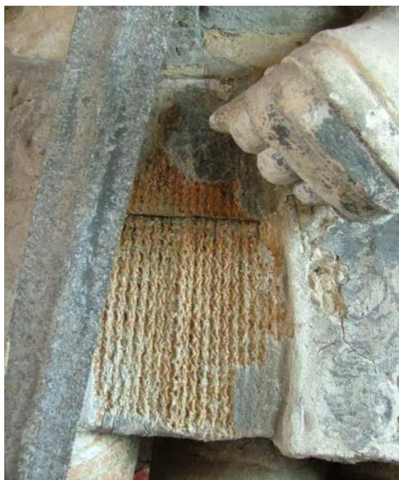
Conserveren. De beelden op het Veeerse raadhuis dateren uit het begin van de zestiende eeuw en zijn gemaakt in een zachte kalksteen (Avendersteen). Ze hebben ongeveer 400 jaar de elementen getrotseerd, waarschijnlijk door het behandelen van de steen met een verf en verguldsel, waarvan op de foto nog restanten te zien zijn
