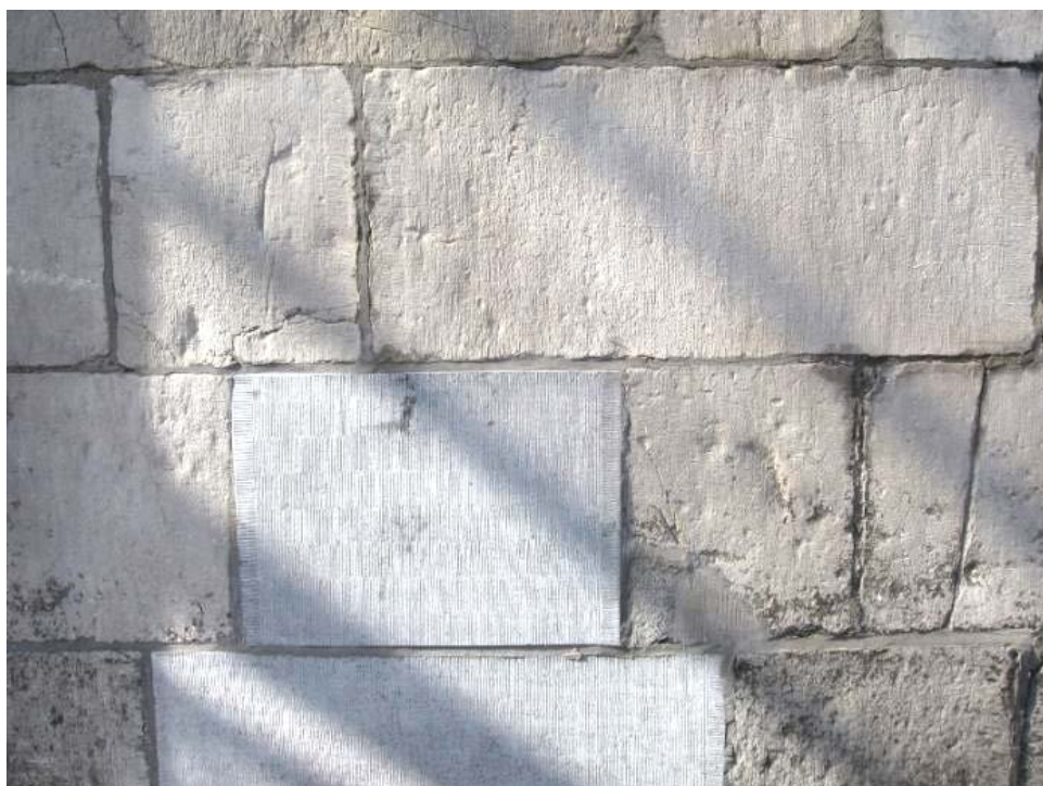
Imiteren. De oude blokken Naamse steen aan de gevel van het stadhuis van Maastricht zijn eerst met de hand vlak gemaakt en daarna pas gefrijnd. Recente vervangingen met lisse hardsteen (midden en midden onder) zijn vlak gezaagd en daarna gefrijnd. Het eindresultaat sluit niet goed aan bij de oorspronkelijke omgeving, omdat het de onvolkomenheden van het handwerk mist en het materiaal anders is. Het gaat hier om een imitatie.
