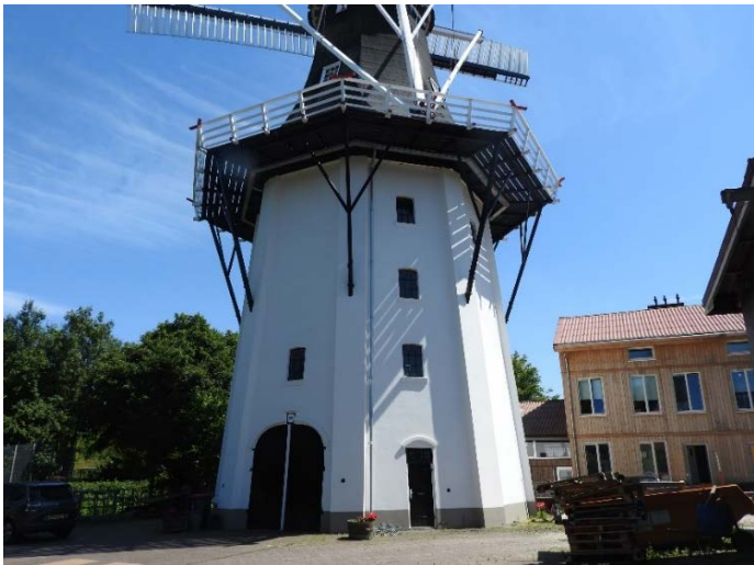
Buitenschilderwerk op een gepleisterde steenachtige ondergrond
