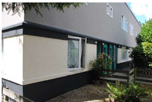
Buitenschilderwerk op beton.
