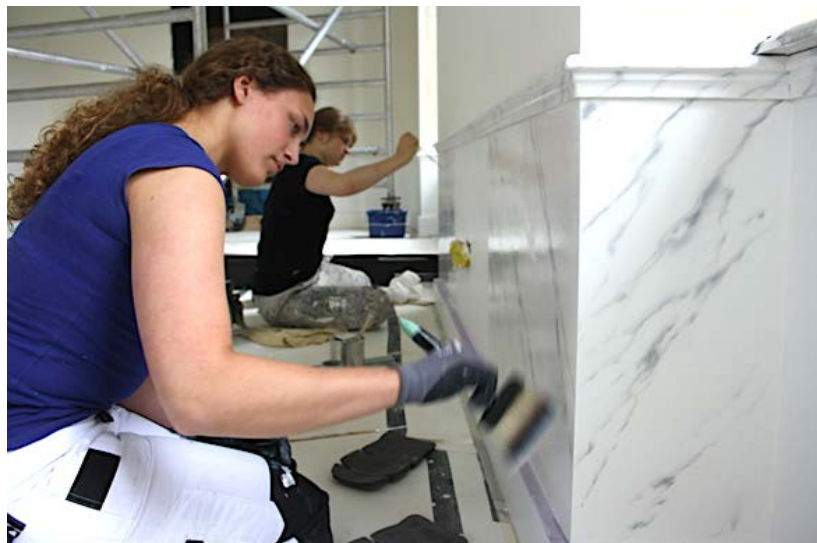
Het aanbrengen van een imitatie van witmarmer.
