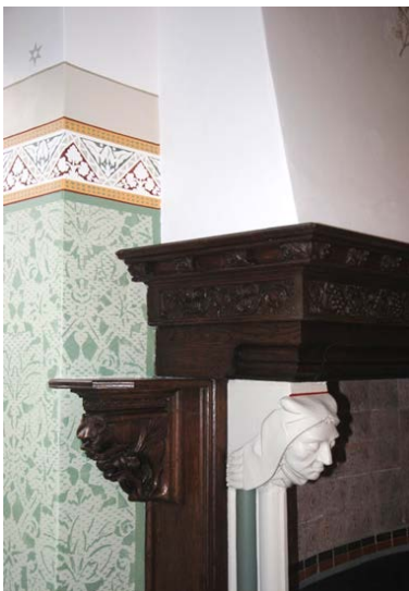
Binnenschilderwerk op steen afgewerkt met decoratief sjabloneerwerk.
