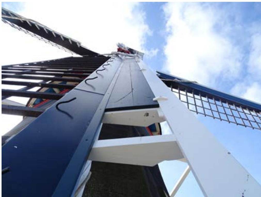
Buitenschilderwerk met een dampopen systeemverf
