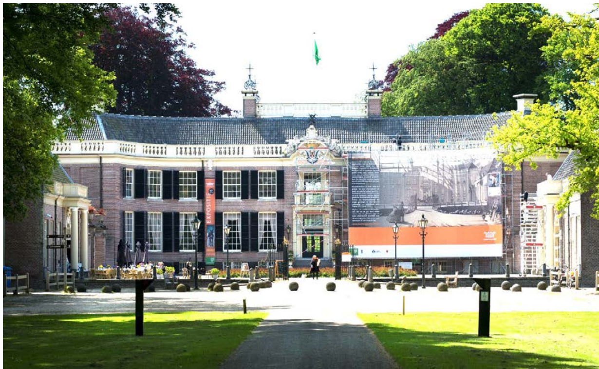
Onderhoud en restauratie van schilderwerk aan monumenten.
