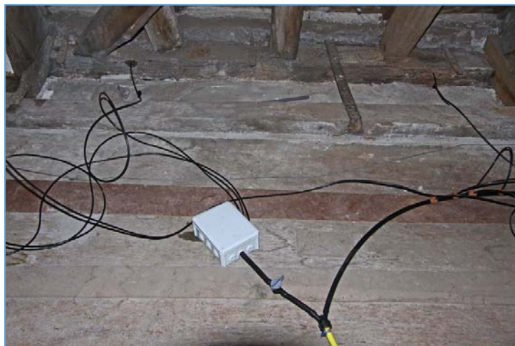
Drukloos injecteren van muurplaten met aantasting door de bonte knaagkever (grote houtwormkever)
