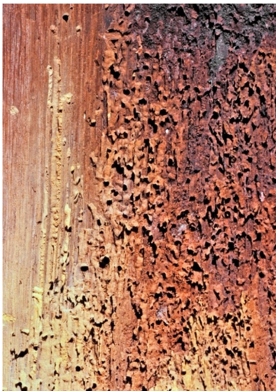
Aantasting van een 16-eeuws eikenkozijnstijl door de kleine houtworm (Anobium punctatum).
