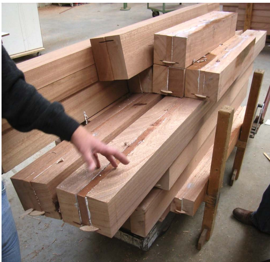
Voorbeeld van samengestelde houtdoorsneden
