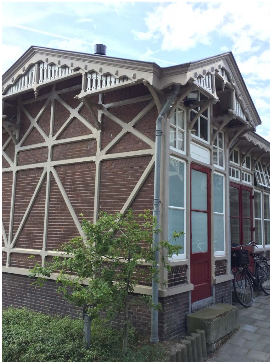
Historisch timmerwerk aan gevels bestaat niet alleen uit kozijnen met ramen, deuren, luiken en persiënnes, maar ook bijvoorbeeld uit lijstwerk aan goten, schoorstenen of balustrades.
