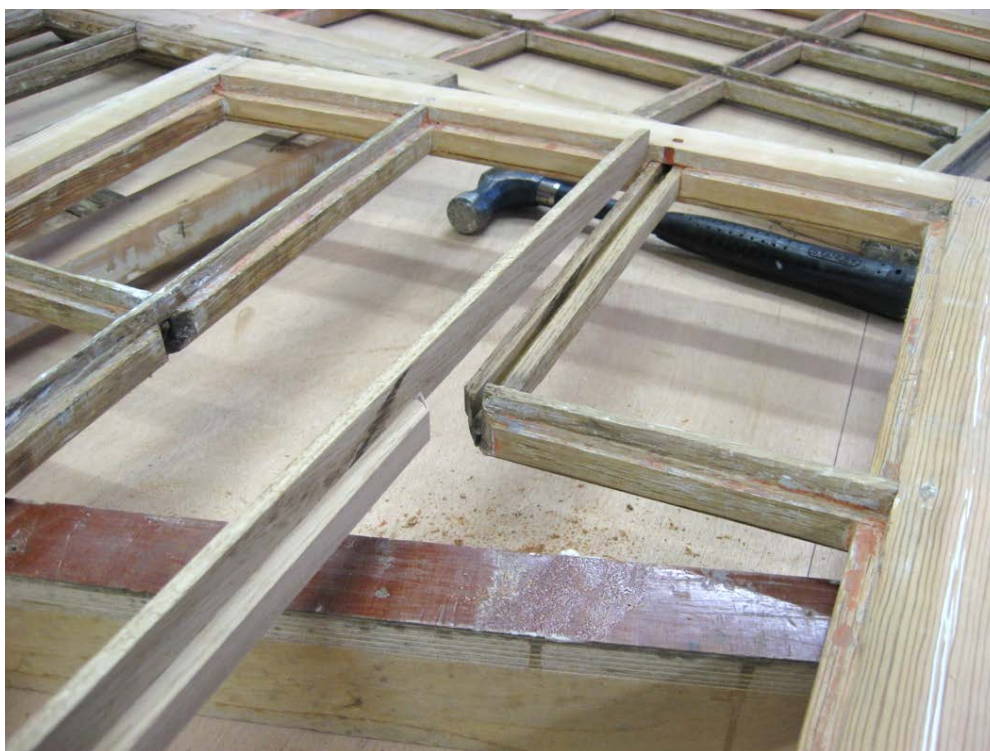
Reparatie aan een buitenraam. Stijlen en dorpels van grenen zijn intact. Aan de eiken roeden wordt veel reparatiewerk verricht. In deze situatie is gestreefd naar maximaal behoud van oud materiaal.
