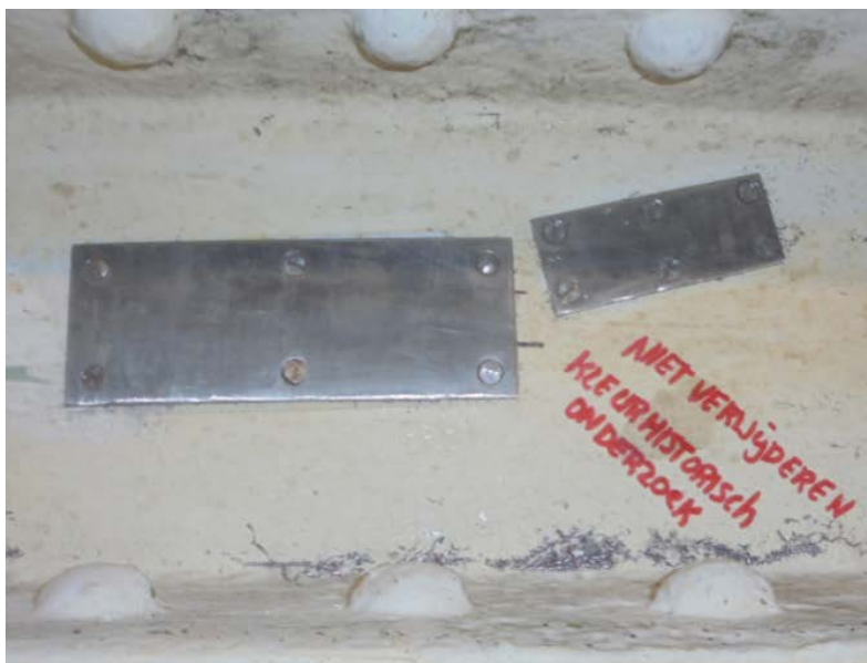
Figuur 4. Afdekplaatje bij kleurhistorisch onderzoek.
