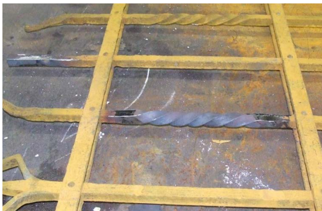
Figuur 17. Ingelast stuk getordeerde spijl.
