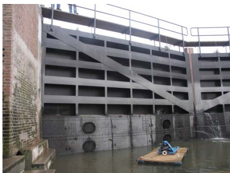
Figuur 22. Sluisdeur, hersteld en verzwaaard i.v.m. hogere veiligheidseisen, waarbij oorspronkelijke delen zijn gehandhaafd. Hierdoor kan de sluisdeur een hogere mechanische belasting aan.
