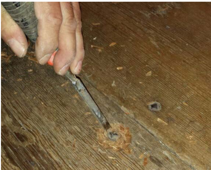
Afb. 31: Nagels moeten gemakkelijk te verwijderen zijn zonder dat daarbij het hout wordt beschadigd wanneer parket uitgenomen moet worden. Hier wordt de omgeving met een beitel (lelijk) vrijgemaakt. Dat is in conflict met de zorgvuldige aanpak.
