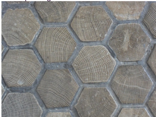
Afb.2 en 3: Detailfoto's van een parketvloer met zeskantige blokjes kopshout in teer gelegd en een vloer met rechthoekige blokjes in visgraatverband. Laatstgenoemde komt het meest voor.
