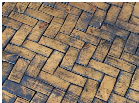
Afb.2 en 3: Detailfoto's van een parketvloer met zeskantige blokjes kopshout in teer gelegd en een vloer met rechthoekige blokjes in visgraatverband. Laatstgenoemde komt het meest voor.
