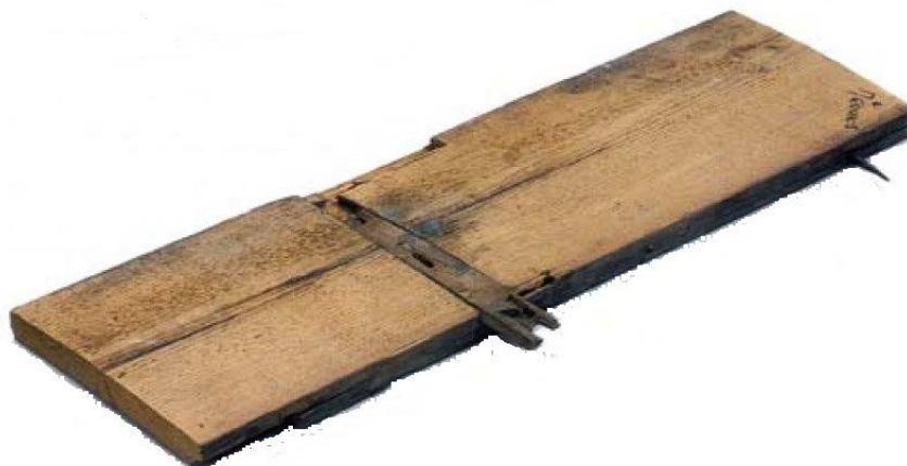
Afb. 12: Onderaanzicht van een zeventiende-eeuwse plank. Links van het midden is een wig zichtbaar, die op de balk gespijkerd wordt. Door de plank over de wiggen te schuiven wordt de plank, 'blind' en zonder te spijkeren, aan de balken bevestigd.
