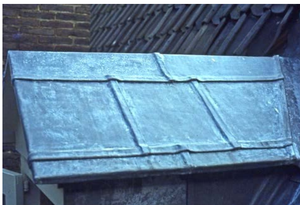
Dakkapel afgedekt met verschervend aangebrachte loodplaten.
